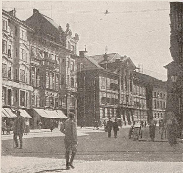
Abb. 36. Das Landhaus, durch den neuen Gebau in seiner Wirkung beeinträchtigt.
