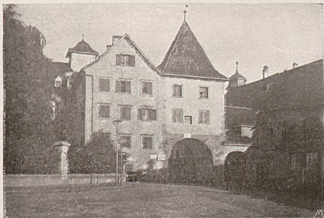
Abb. 15. Meran: Vintschgauer Tor nach dem Umbau.
