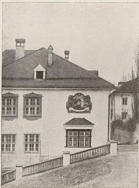
Abb. 75. Schulhaus in Matri. Von Baurat S. Menardi.
