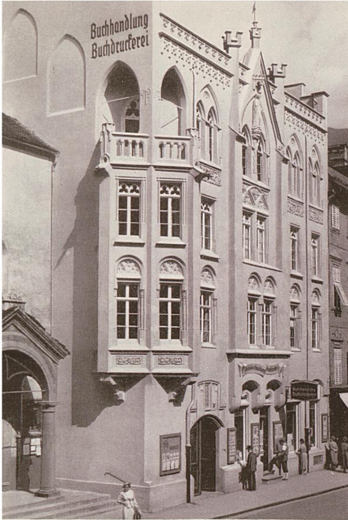
Das Hauptgebäude Maria-Therese-Strasse 40
