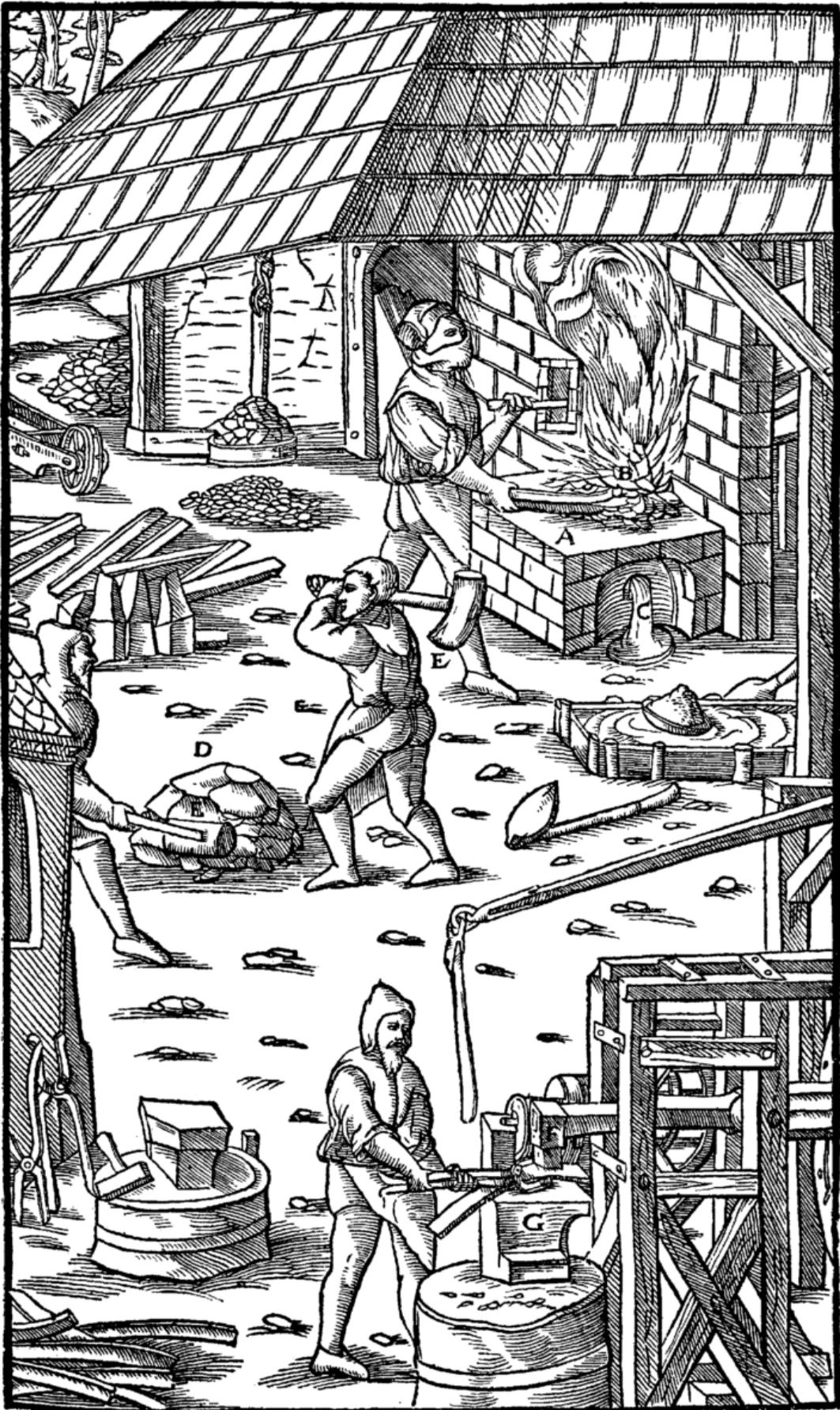
Der Herd A. Der Beschickungshaufen B. Der Schlackenabfluß C. Der Eisenklumpen (Maffel) D. Die Holzhämmer E. Der große eiserne Hammer F. Der Amboß G.
