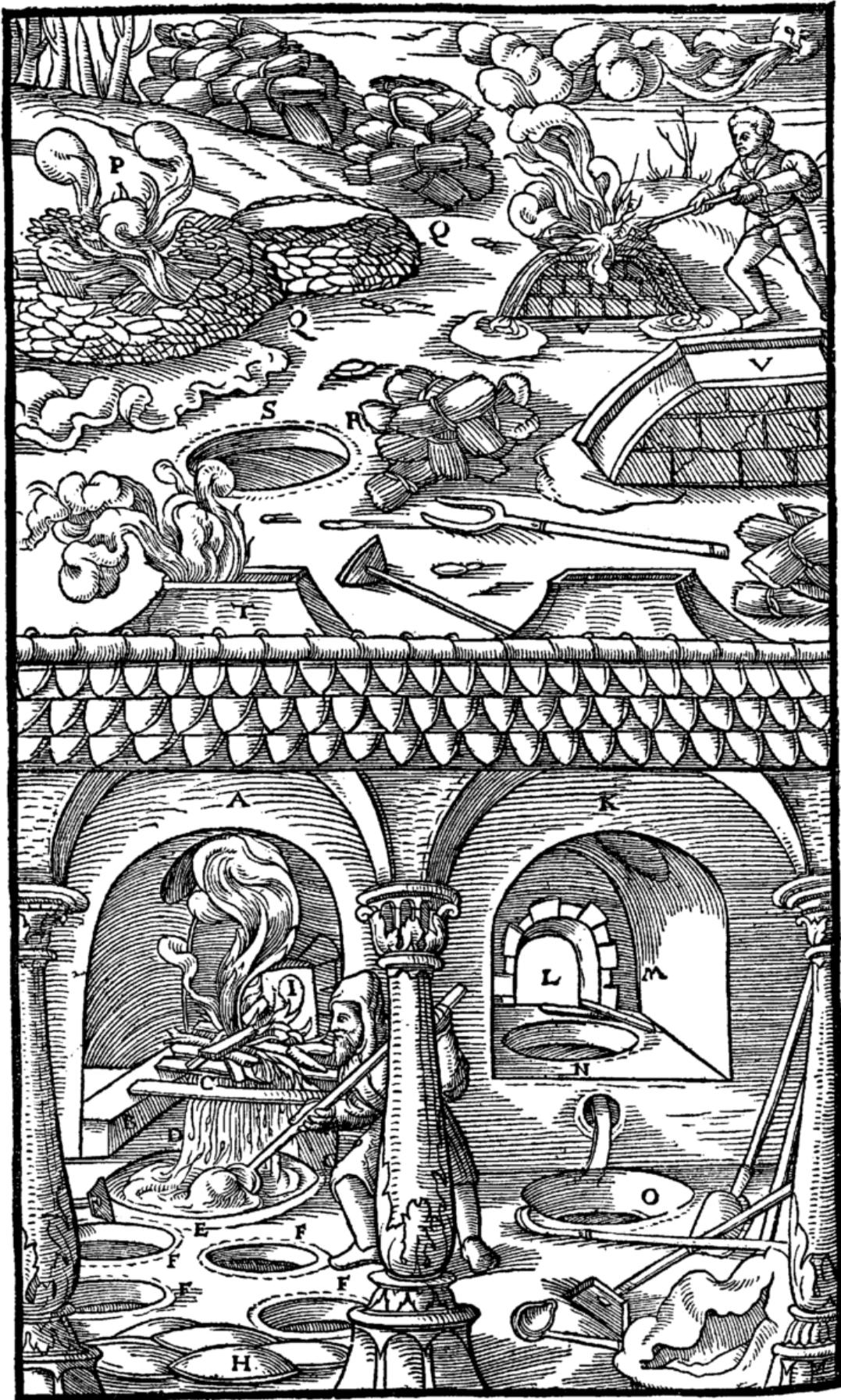
Der Kärntner Ofen A. Die eine niedrige Mauer B. Holz C. Das Erz mit dem heraustropfenden Blei D.
