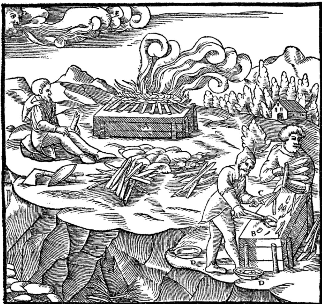
*Die Feuerstätte, auf der das Erz erhitzt wird A. Die Feuerstätte, auf der ausgefaigerte Wismutkügelchen liegen B. Die Zange C. Die Mulde D. Der Wind E.*
