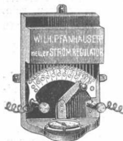
**Pfanhauser's neuer Stromregulator** (Stromschwächer und Stromanzeiger vereinigt), ein unentbehrlicher Apparat, welcher die Stärke des galvanischen Stromes anzeigt und womit die Stromwirkung nach Belieben mehr oder weniger abgeschwächt, auch ganz unterbrochen werden kann.
