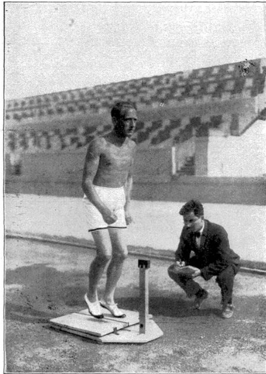
Abb. 206. Laufschnelligkeitsprüfer (nach Schulte). Messung des Beintempos beim Lauf auf der Stelle durch elektrische Kontaktbretter.
