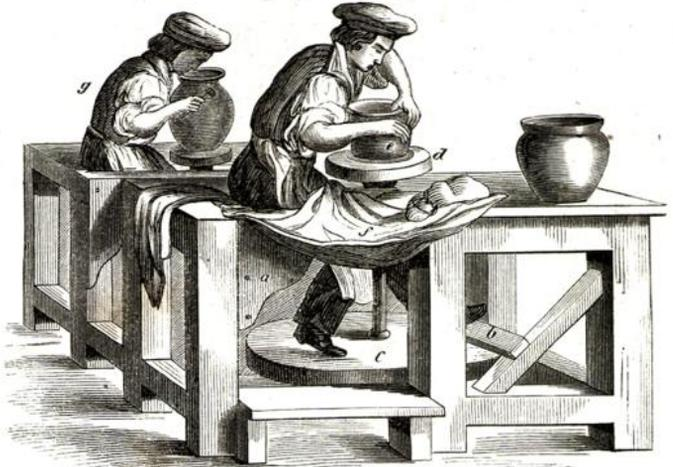
Die ganze Vorrichtung ist in Fig. 1222 mit dem arbeitenden Töpfer gezeichnet. *a* ist das Sitzbrett, *b* das Fußbrett, *c* die Frettscheibe, *d* die Drehscheibe, *e* das Arbeitsstück, *f* sein Thonvorrath, der auf einem feuchten Tuche liegt.
